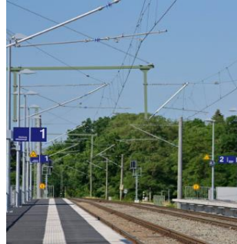
Ausbau Kreuzungs- bahnhöfe Hiltersdorf u. Freihöls
